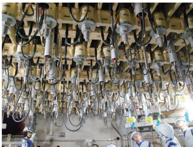
福島第二原発の炉心の底部、制御棒の下端
