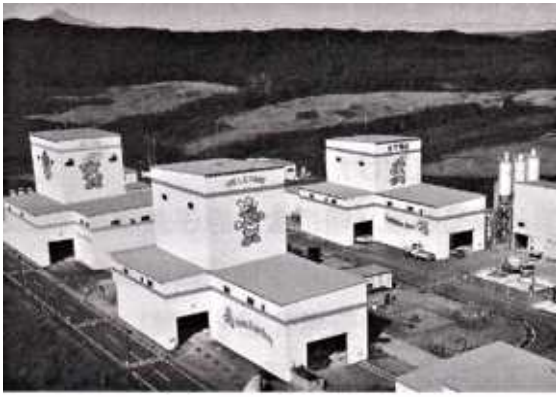
3つの立坑外観（深地層研究センター）
