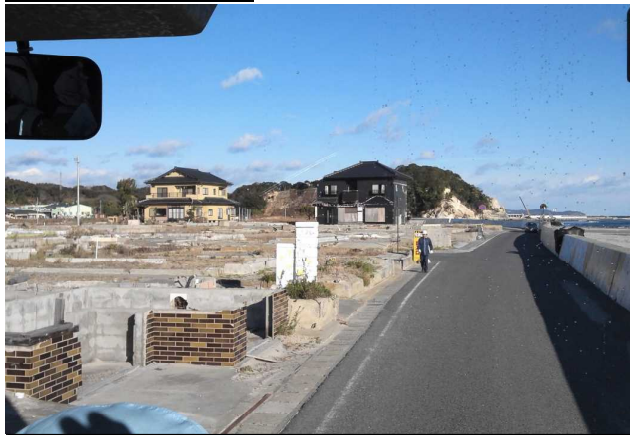
津波被害の大きかった小名浜から広野町周辺
